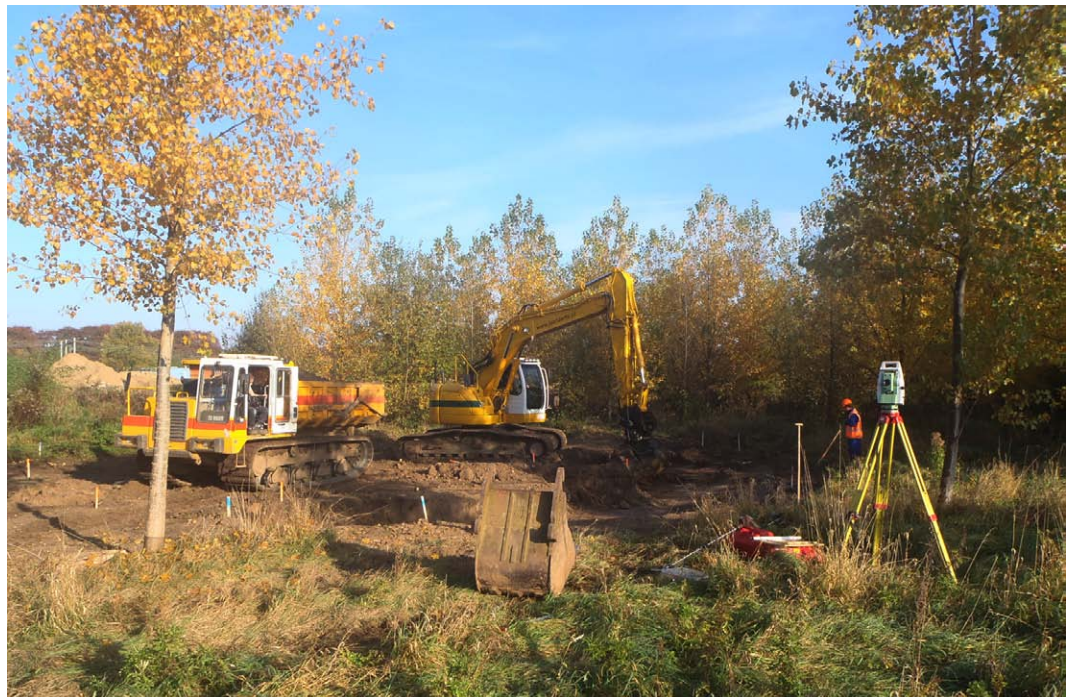
Afb. 2.8 Begeleiding van de aanleg van twee poelen.
