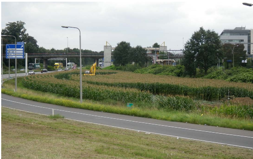
Afb. 2.6 Aanleg van de proefsleuven ter hoogte van Knooppunt Europaplein.
