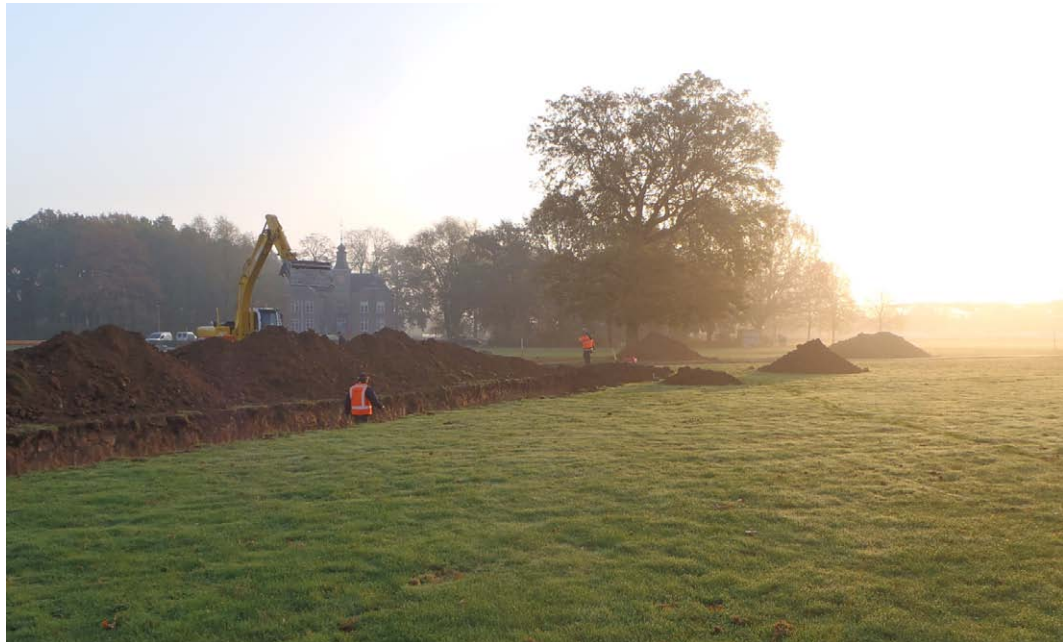
Afb. 2.10 Aanleg van een proefsleuf in het plangebied Geusseltvijver.
