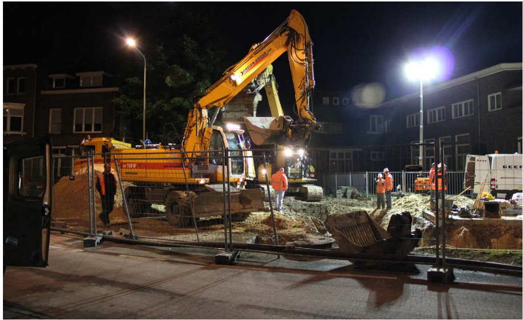
Afb. 2.7 Impressie van de nachtelijke werkzaamheden.
