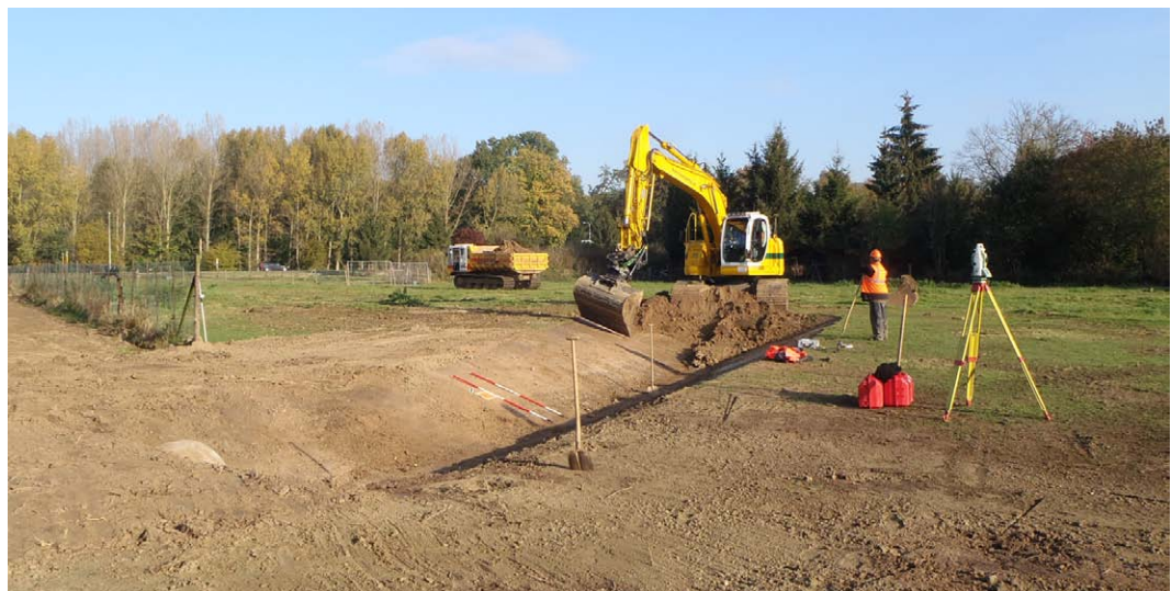
Afb. 2.16 De begeleiding bij de aanleg van de Kanjelbeek.
